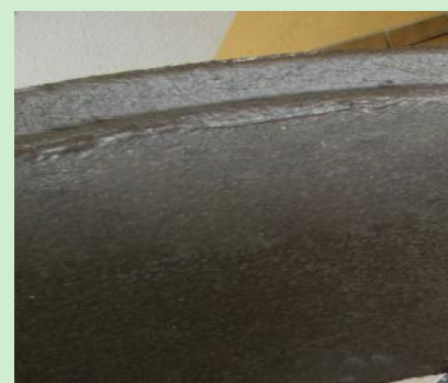
Beschichtung eines Behälterteiles zur Silageeinlagerung.
