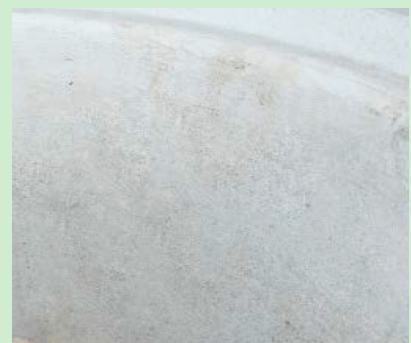
Maleki-SWP 270 auf Beton zum Schutz vor korrosivem Angriff durch Silage.
